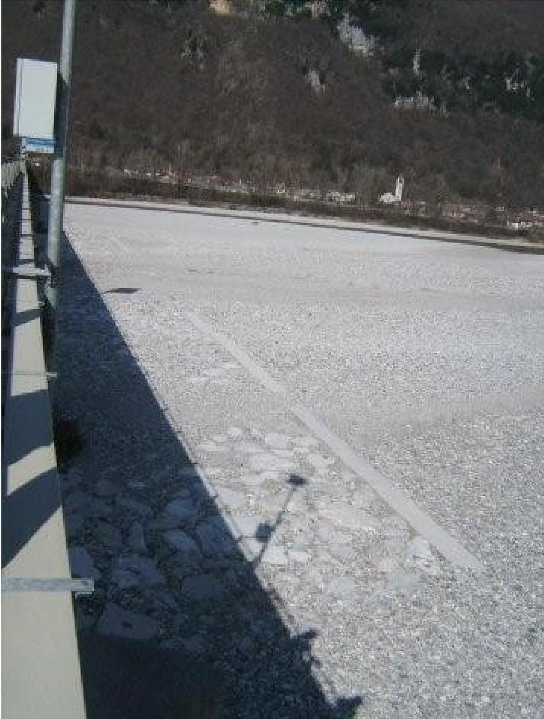
**In questo caso si tratta di un livellamento trasversale dell'alveo sia a salvaguardia del nuovo ponte sia per consentire più agevoli e precise misurazione di portata. Per questo motivo l'opera è stata eseguita con caratteristiche di permanenza nel tempo (ciglio di cemento armato e consolidamento dei bracci di corrente con massi da scogliera)**
